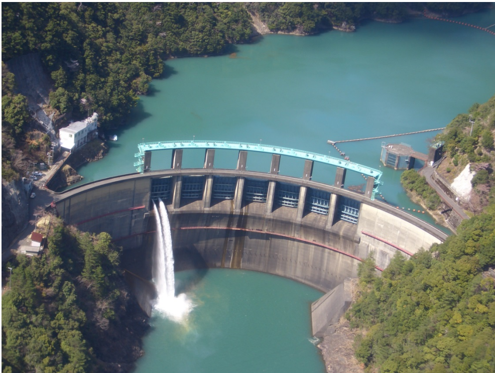
十津川第二発電所 二津野ダム (アーチ式コンクリートダム)
