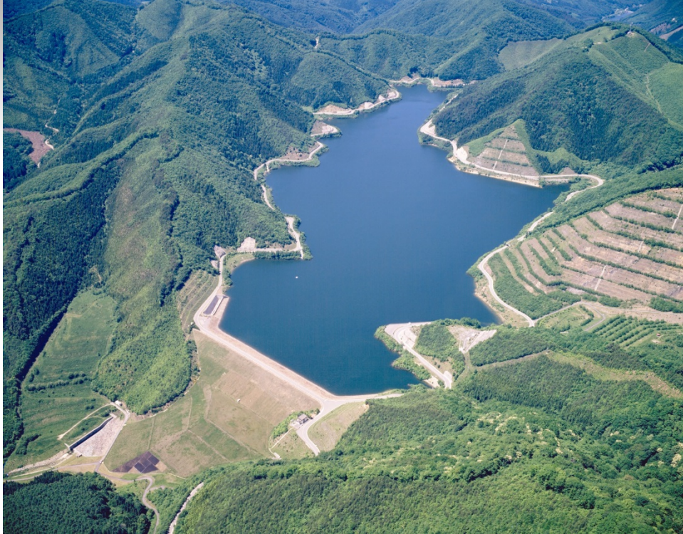
福島県下郷発電所 大内ダム (ロックフィルダム)
