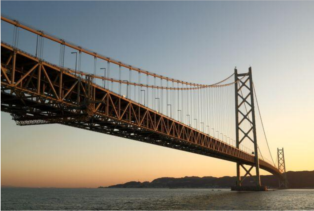
明石海峡大橋：中央支間1991mの世界最長の吊り橋
