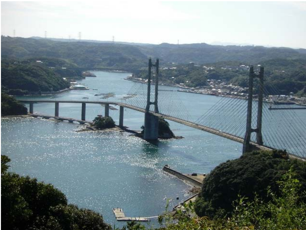
呼子大橋：海上に架橋された国内最大級のPC斜張橋
